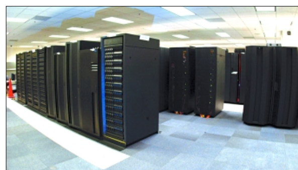
Die Anschaffung von Datensicherungssystemen stellt eine große Belastung für Haushalte dar. Es stellt sich die Frage, ob es nicht sinnvoller wäre, die Datensicherung als Service mit nutzungsabhängiger Abrechnung zu beziehen.
